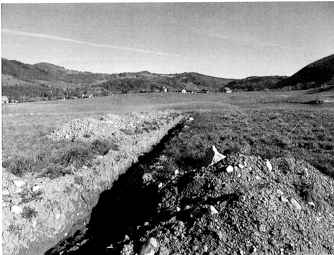
Figure 3 - Fossé sud qui mène de la carrière jusqu'à l'étang
