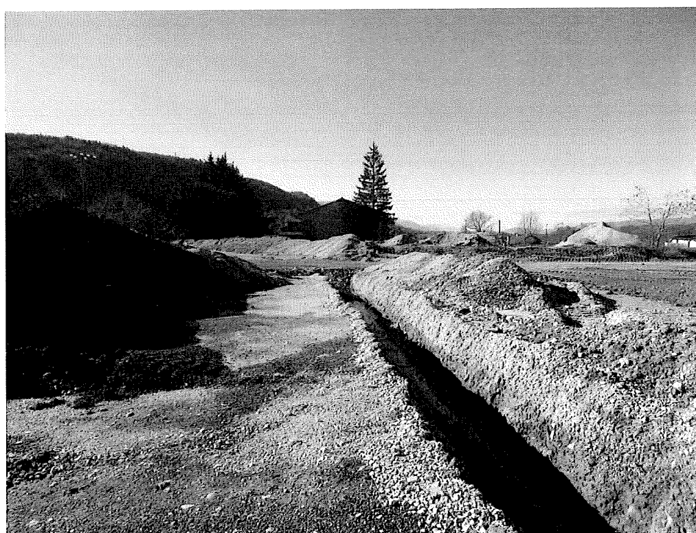
Figure 4 - Fossé sud qui mène de la carrière jusqu'à l'étang
